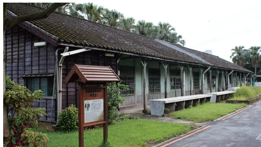
磯小屋建築現況外觀
