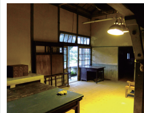
雨天作業室現況
