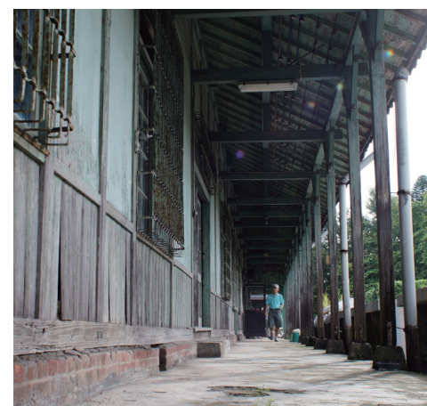
磯小屋正面長廊
